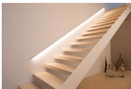
Рисунок 1 – Монтаж светодиодной ленты непрерывной линией
